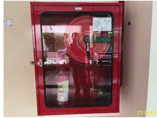
ตู้สายฉีดน้ำพร้อมอุปกรณ์
